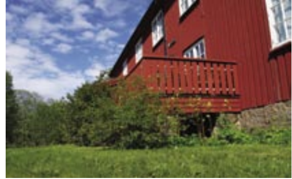
Sist kjente voksested for Hablitzia tamnoides i Norge: Hadsel Prestegård. Planten vokste på husveggen mot verandaen.
